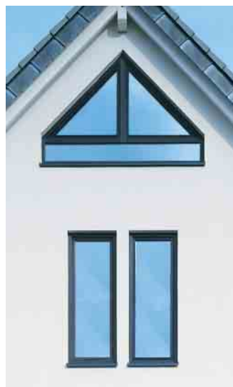
Rechteckige, hochstehende Fenster ohne Sprossenteilung betonen die Vertikale und optimieren den Lichteinfall.
