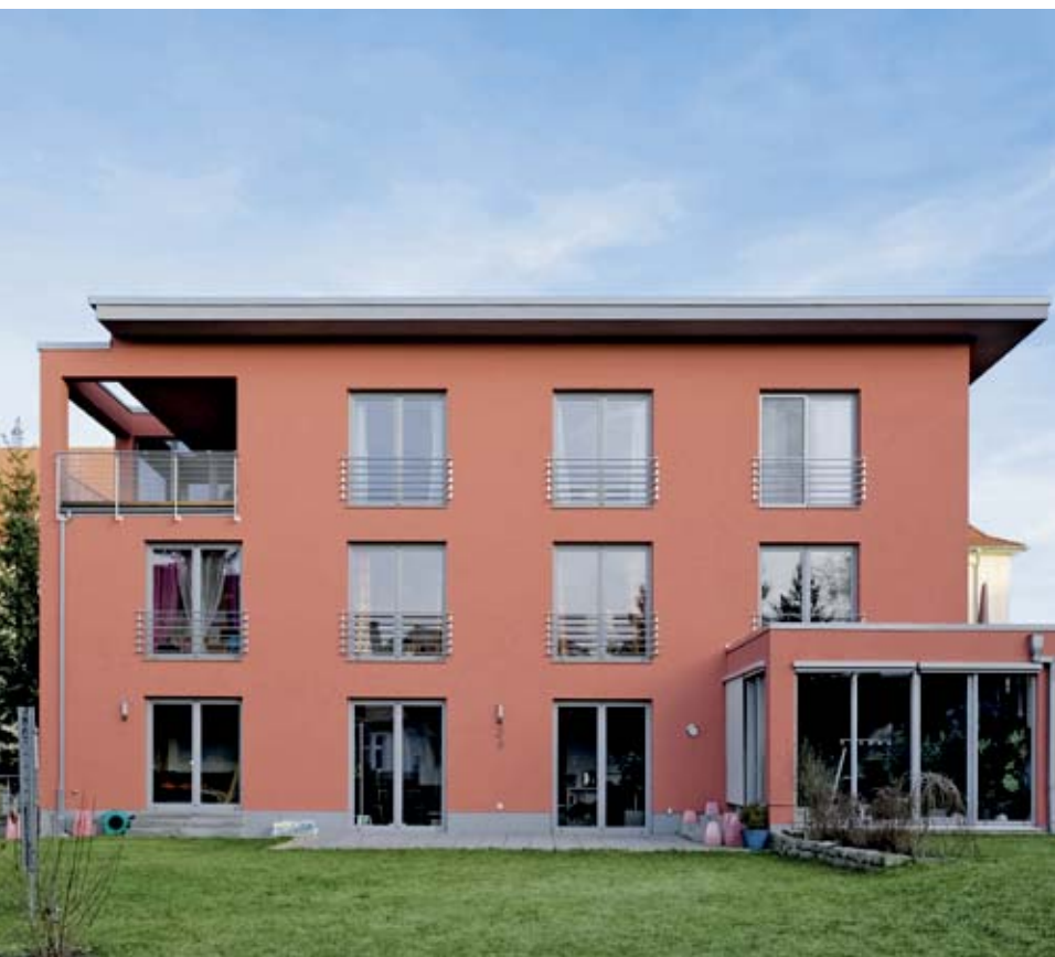
Mehrfamilienhaus, Erfurt, Deutschland Apartment block, Erfurt, Germany
